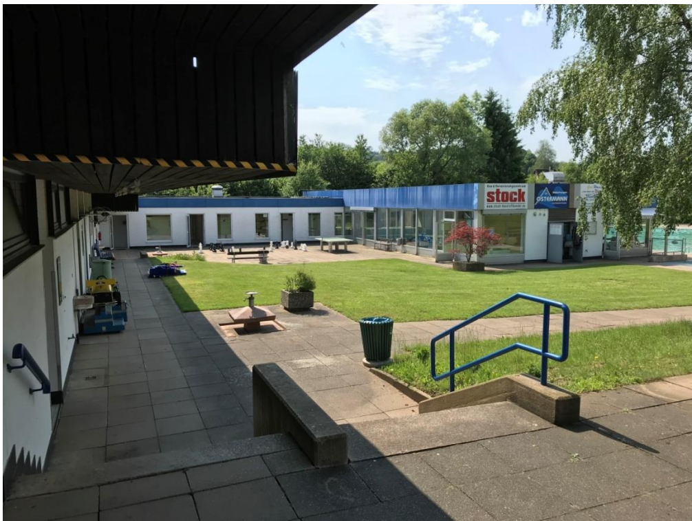
Abbildung 5: Hochbau, links Sanitärgebäude, mitte Technik, rechts Einschwimmhalle
