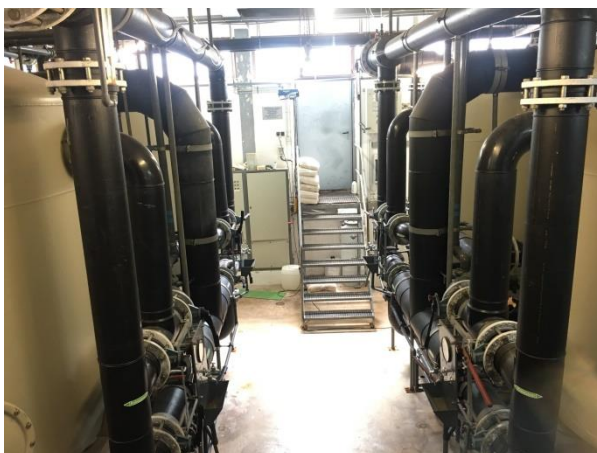
Abbildung 9: Mehrschichtfilter und Dosierung
