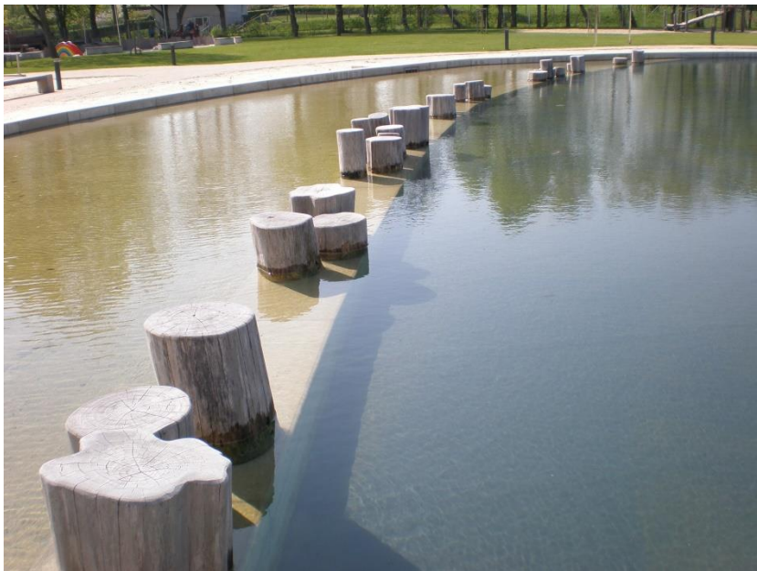
Abbildung 32: Abgrenzung Kleinkind-Nichtschwimmer im NO Uferbereich
