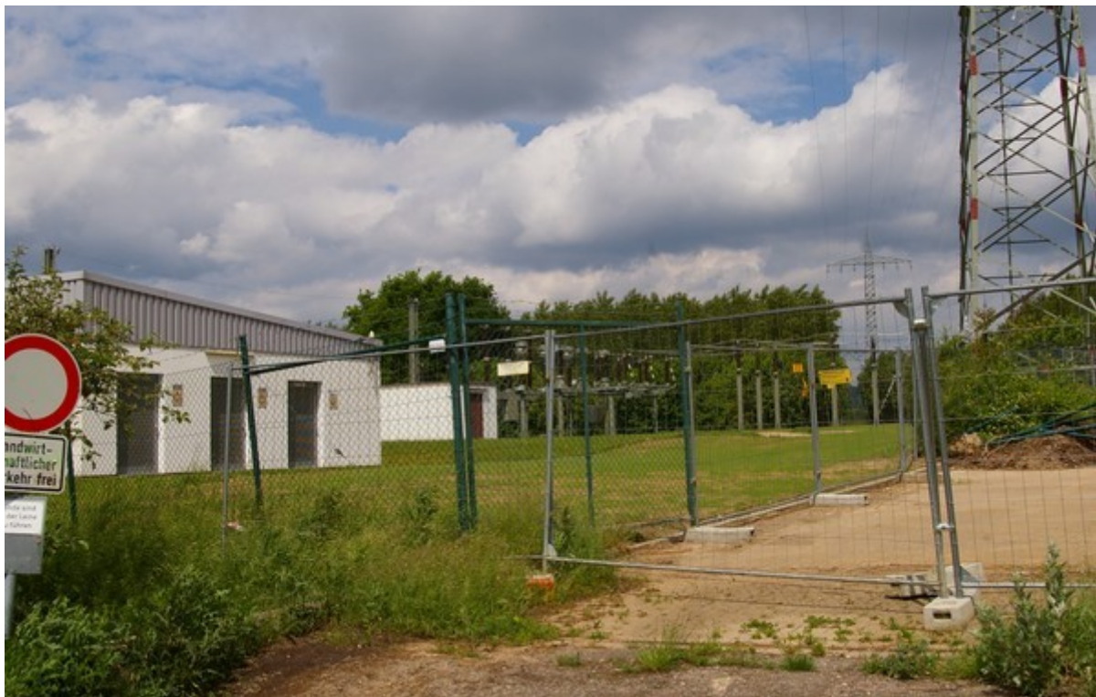
Abbildung 8: Trafostation mit Mast einer Hochspannungsleitung
