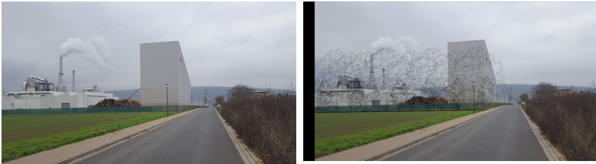
Abbildung 7: Hochregallager aus östlicher Richtung „Am schwarzen Stuken“ (Kamera Standort 01)
